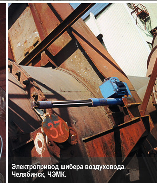
Электропривод в системе подачи сыпучего сырья на МНР. Красноярск, алюминиевый завод.
