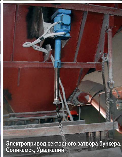
Привод шиберного затвора бункера, Соликамск, Уралкалий
